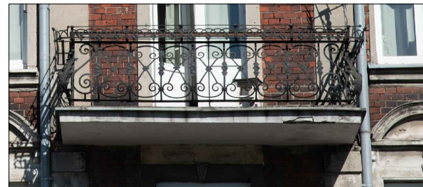
elevacja frontowa: balustrada balkonu
