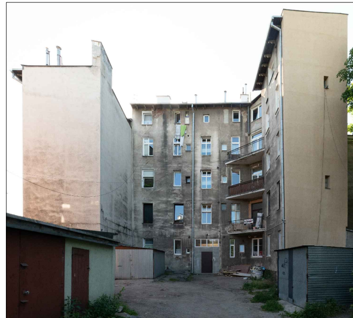
widok od strony podwórza
